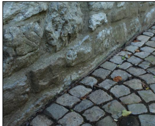
Figure 18 : Membrane étanche placée en pied de mur – Chapelle Saint-Roch de La Calamine.
