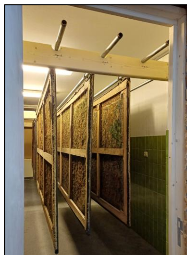
Figure 35 : Système de tringles pour les tapisseries de l'église Saints-Antoine-Ermite-et-Apolline de Pepinster.
