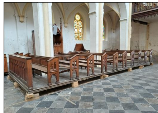
Figure 32 : Aération sous l'estrade des bancs – Église Saint-Laurent de Prayon (Trooz).
