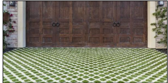
Figure 13 : Exemple de sol béton-gazon ( https://www.sol-exterieur.be/materiaux/dalles-a-engazonner ).
