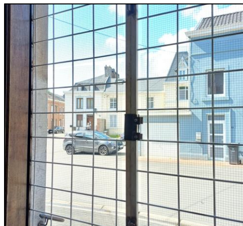
Figure 27 : Exemple de grille amovible dans la feuillure de la porte d'entrée de l'église Saint-Laurent de Prayon (Trooz).
