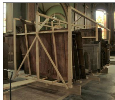
Figure 34 : Structure d'entreposage des lambris de l'église de la Visitation de la Vierge de Dolhain.
