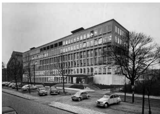
↑ Façade nord et pignon ouest du bâtiment, depuis l'Avenue de la Renaissance, en bordure du parc du Cinquantenaire, 1963. B192652.
